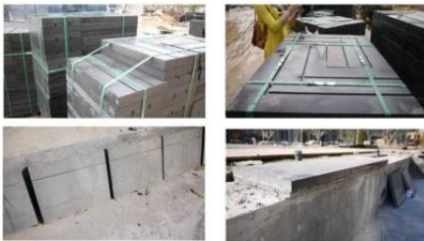
景墙压顶底部切缝，水泥浆挤入后，形成止水带。
