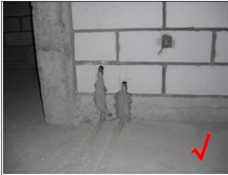
图 3 卫生间给水管从砼反坎接入
