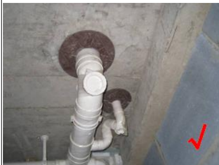
图 4 采用成品吊洞模具封堵管堵
