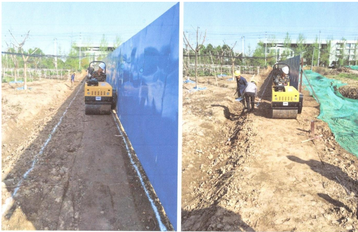
K0+000~K0+080 红线外村民便道施工中
