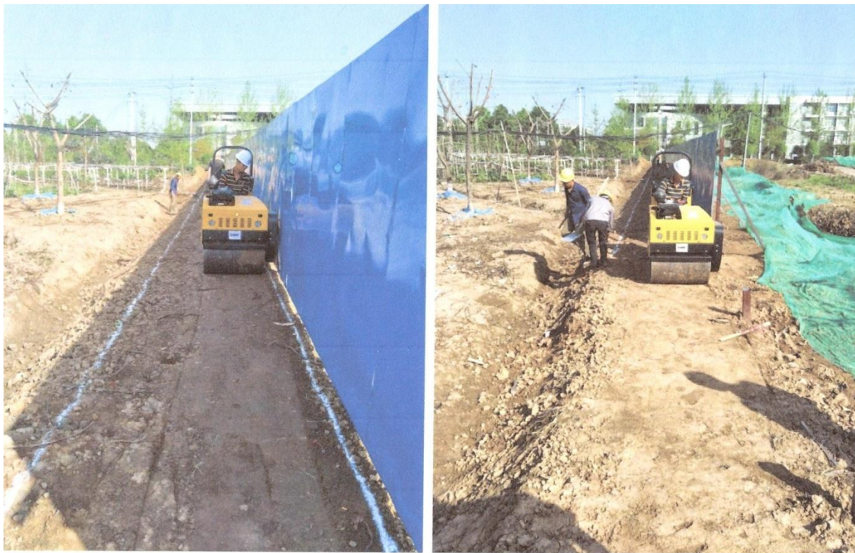
K0+000~K0+080 红线外村民便道施工中
